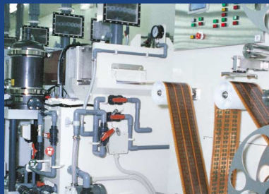
先進の設備による業界屈指の大量生産体制
